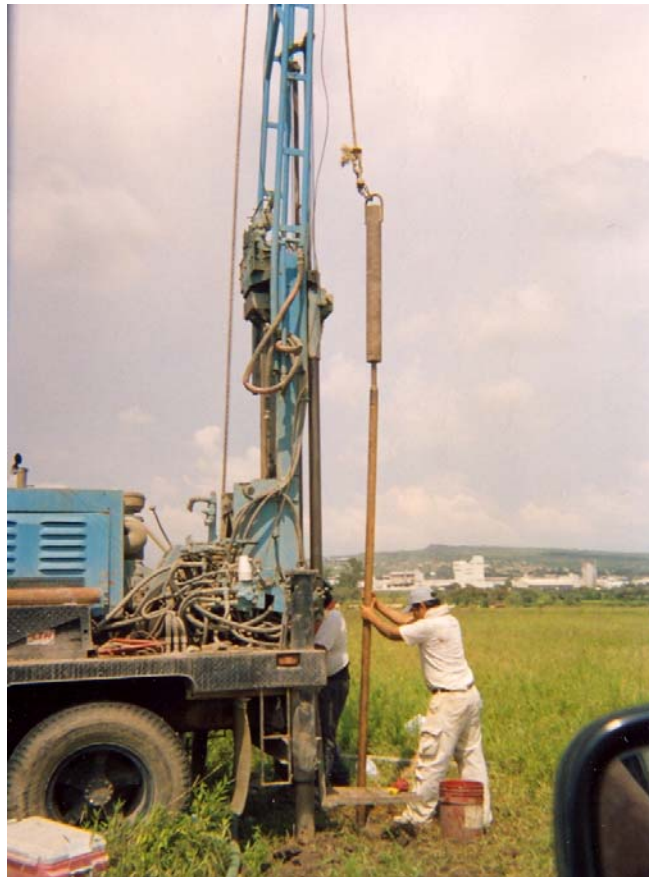
Fotografía 14. Preparación de la herramienta de penetración estándar para obtener muestras alteradas.
