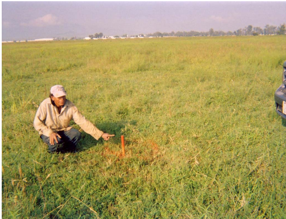
Fotografía 2. Trazo de la ubicación de los sondeos.
