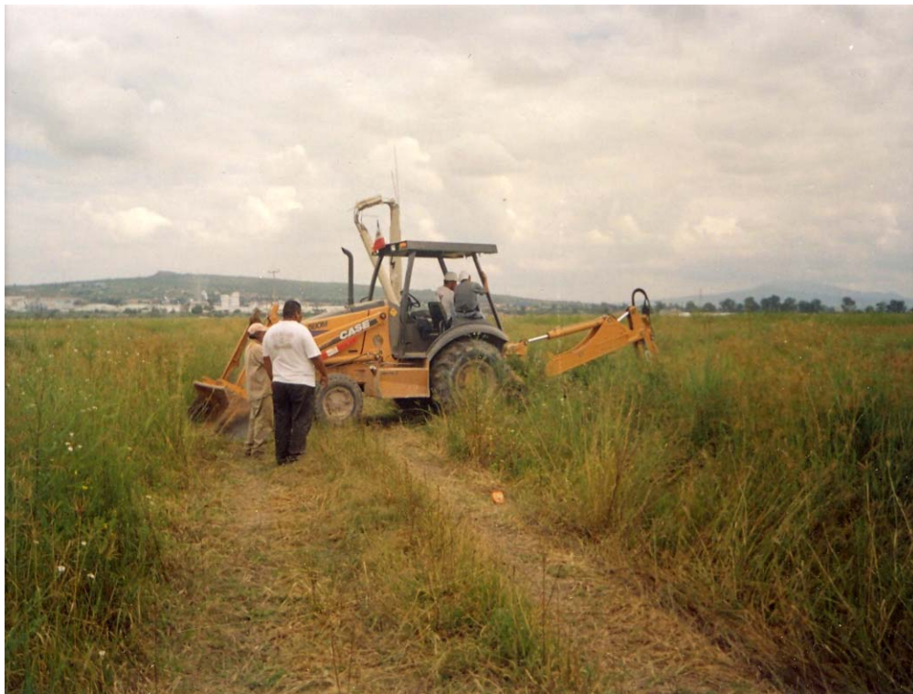
Fotografía 25. Retroexcavadora-cargadora realizando excavación del PCA-1.
