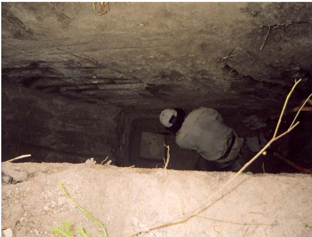
Fotografía 31. Labrado de muestra cúbica inalterada, PCA-1.
