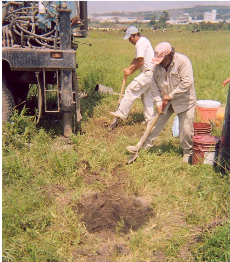
Fotografía 4. Excavación manual de canal y cárcamo para recuperación de lodo de perforación.
