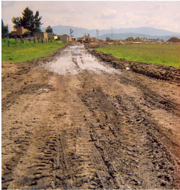
Fotografía 1. Aspecto general del acceso al predio; encharcamientos provocados por la lluvia.
