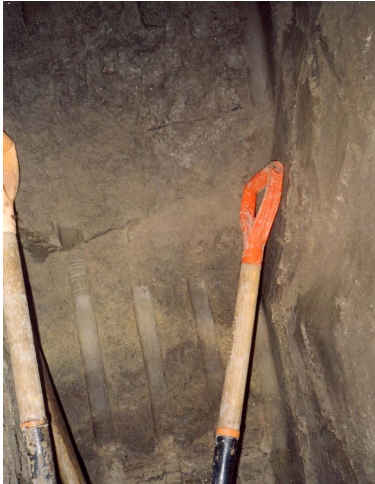
Fotografía 32. Aspecto de la pared de excavación del PCA-1.
