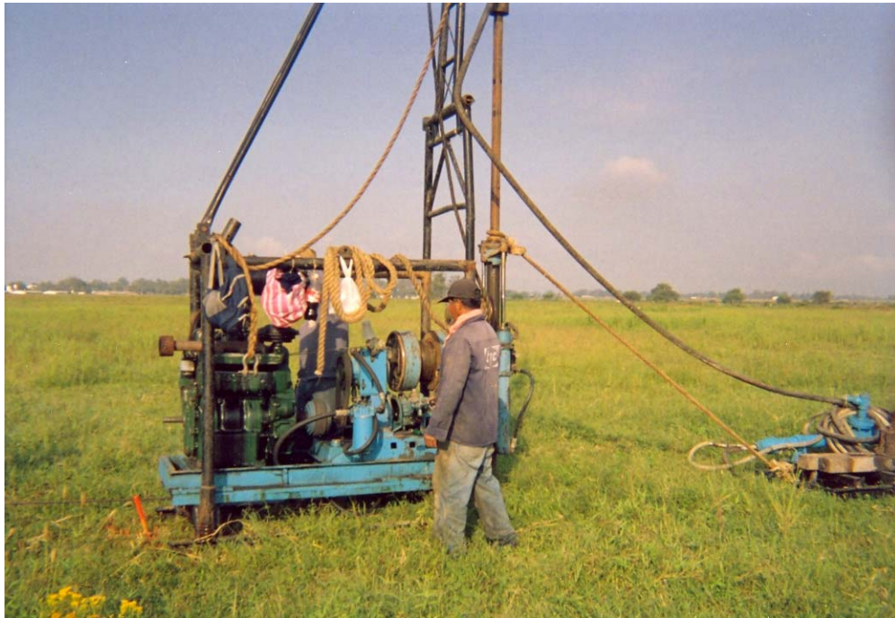
Fotografía 3. Instalación del equipo de perforación Long Year 34 en la ubicación de uno de los sondeos.
