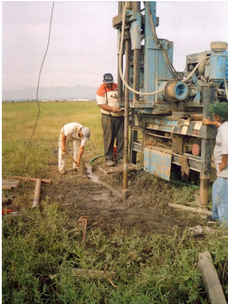
Fotografía 8. Colocación de equipo de perforación C. M. E. para la realización de sondeo mixto.
