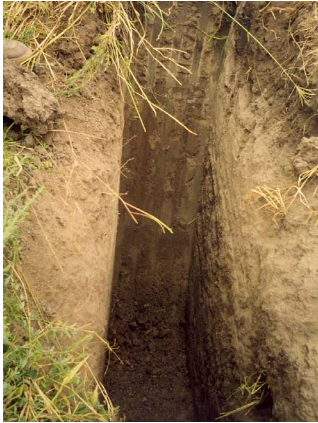
Fotografía 34. Excavación del PCA-2.
