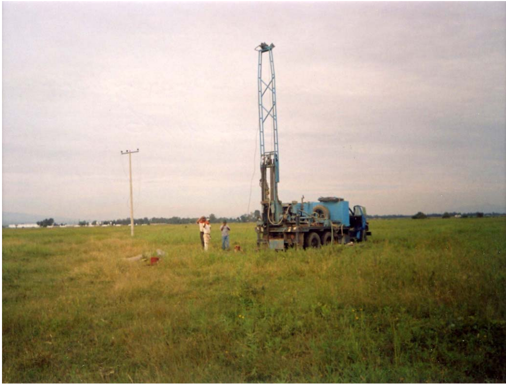
Fotografía 9. Vista general del equipo de perforación C. M. E.
