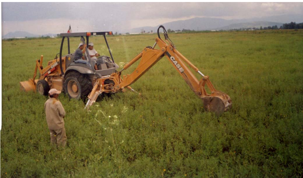
Fotografía 33. Inicio de la excavación del PCA-2, con retroexcavadora-cargadora.
