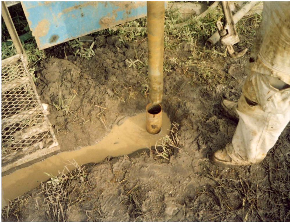
Fotografía 17. Introducción del barril NQ en la perforación protegida con ademe NW.
