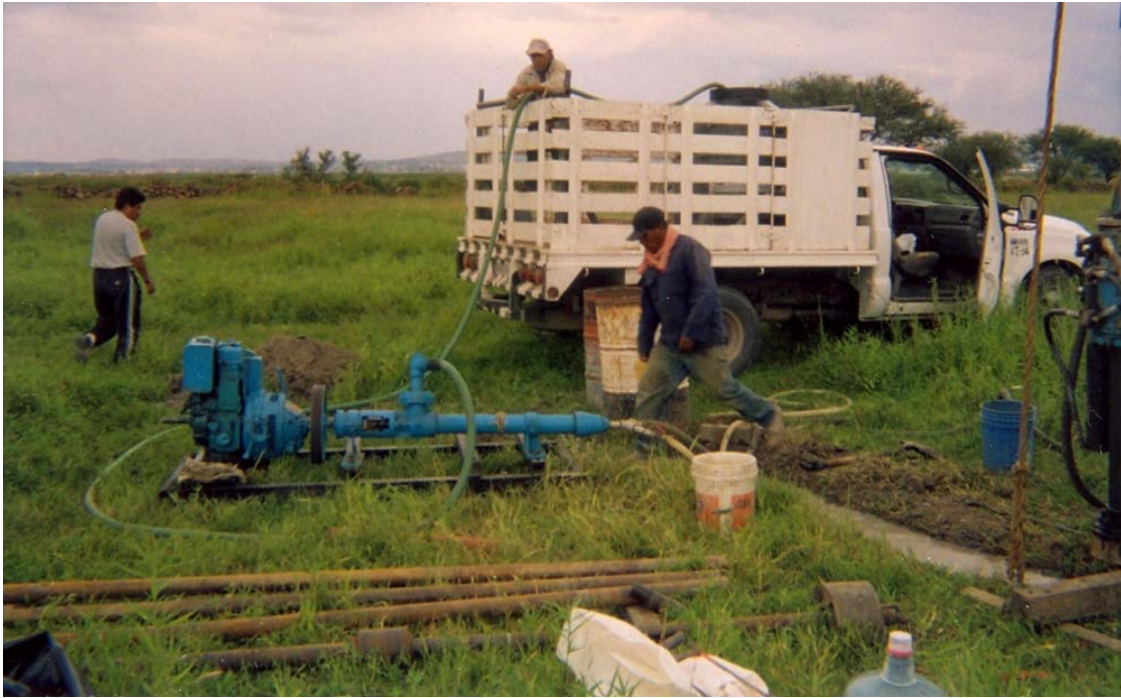
Fotografía 5. Suministro de agua.
