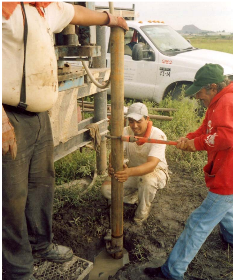
Fotografía 12. Maniobras en la colocación del ademe NW.
