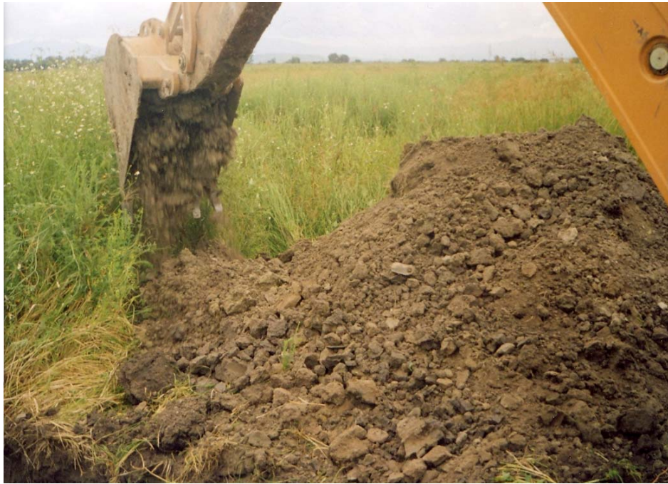
Fotografía 26. Material producto de la excavación del PCA-1.
