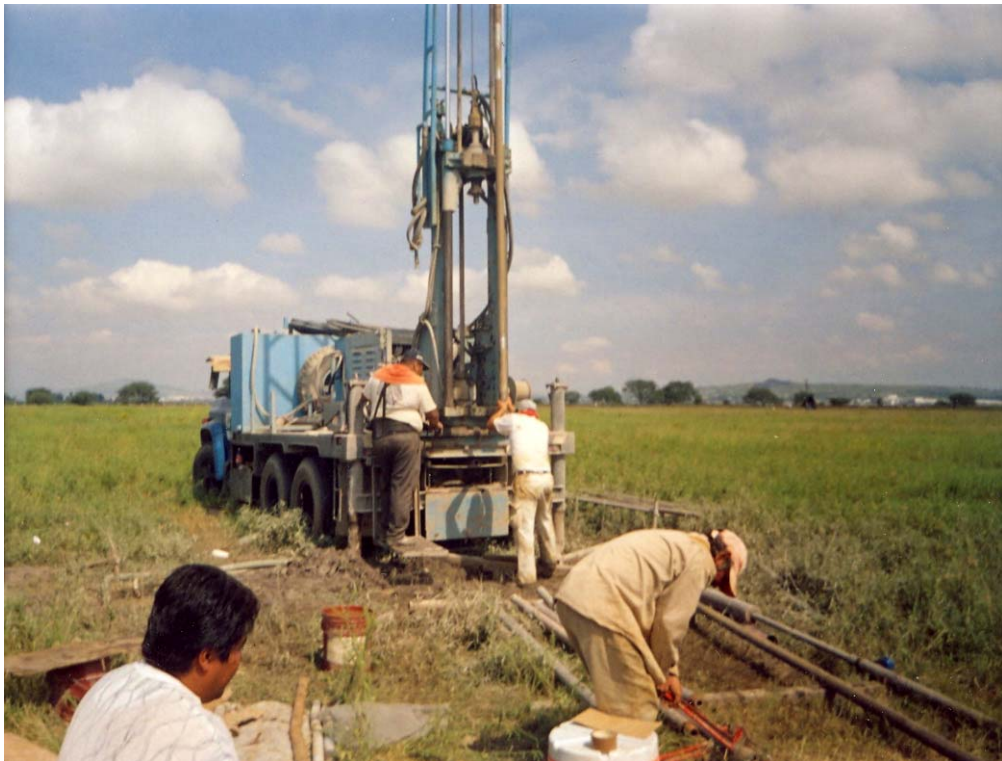
Fotografía 10. Ejecución de sondeo mixto con equipo de perforación C. M. E.
