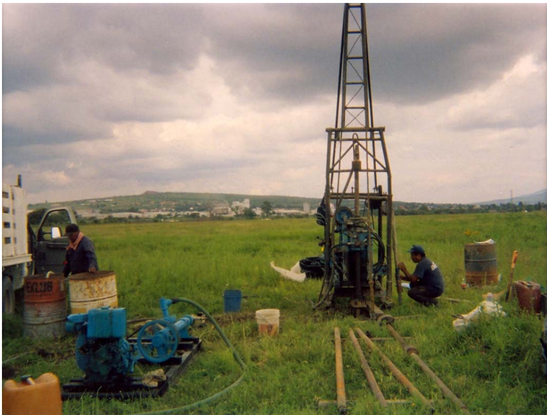
Fotografía 6. Ejecución de sondeo mixto con equipo de perforación Long Year 34.
