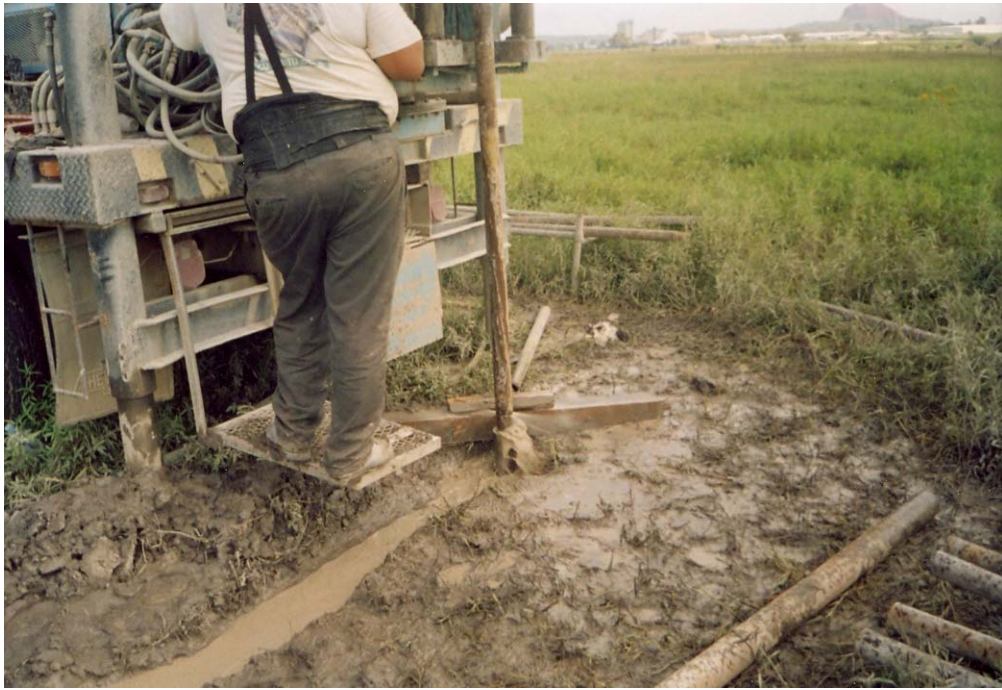
Fotografía 11. Otro aspecto de la ejecución de sondeo mixto con equipo de perforación C. M. E.
