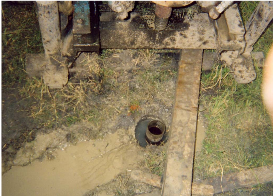
Fotografía 13. Aspecto del ademe NW colocado en la perforación del sondeo mixto.
